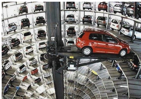
Фиг. 2: Паркинг с автоматизирана система за складиране на автомобили
